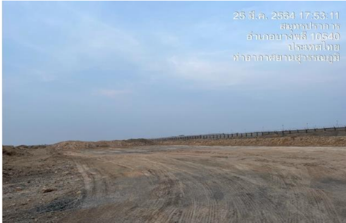
งาน Excavation Sand Embankment
