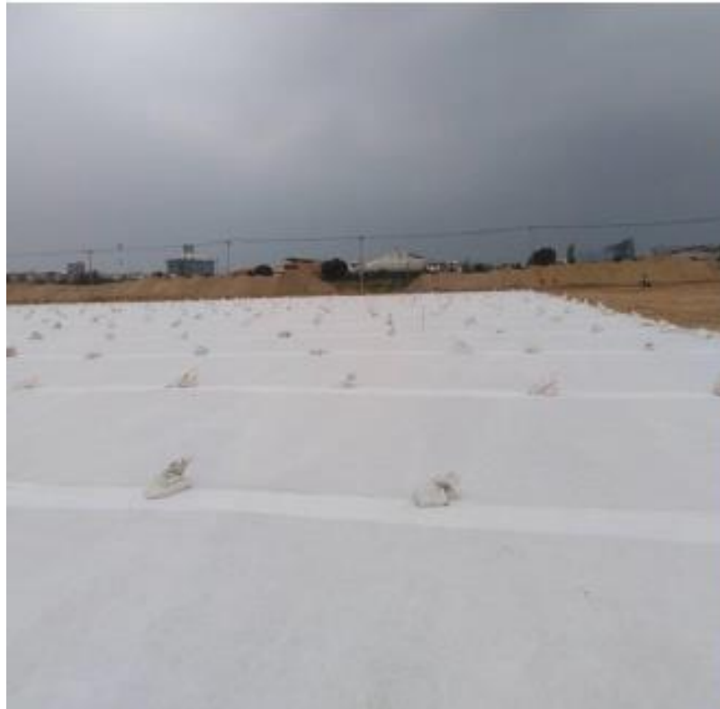
งาน Installation Geotextile
