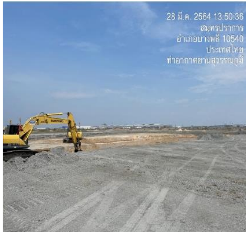
งาน Excavation Surcharge Crush rock
