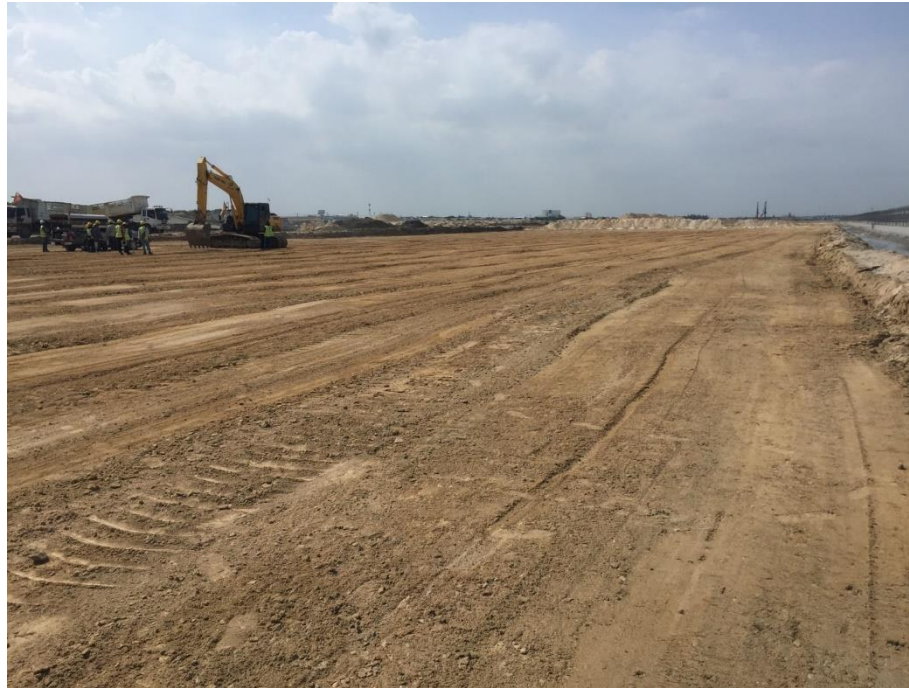
งาน Backfill Sand Blanket
