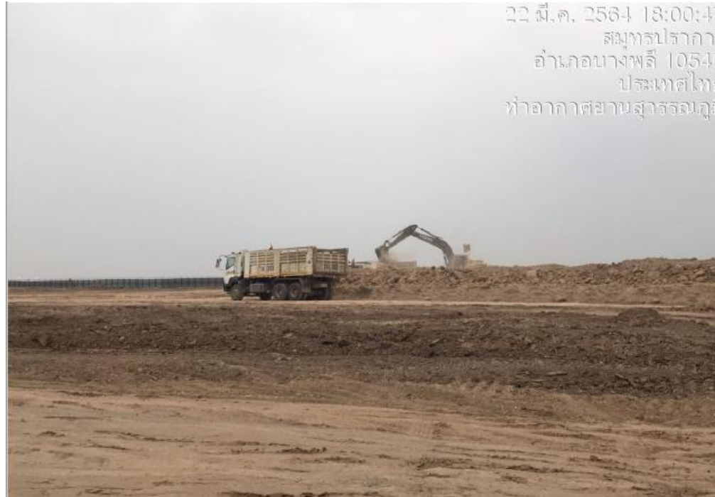
งาน levelling cut & Backfill Subgrade Embankment
