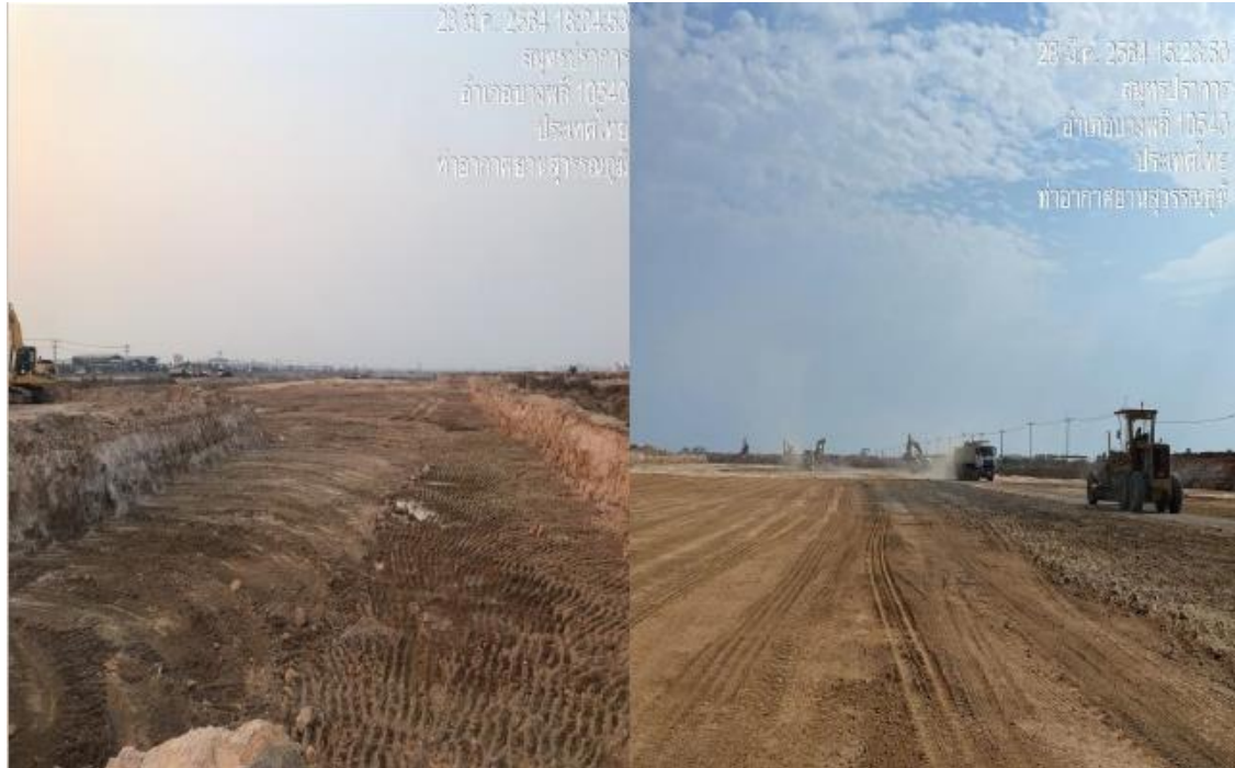
งาน Backfill Subgrade Embankment
