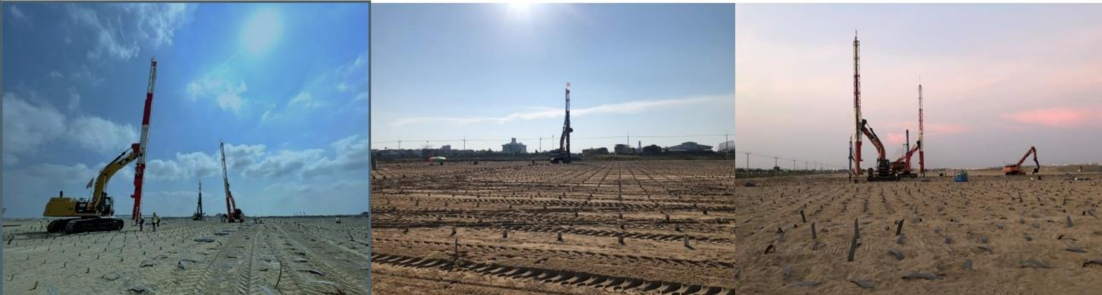
งาน Installation PVD
