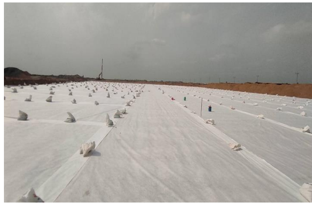
งานปูผ้า Geotextile
