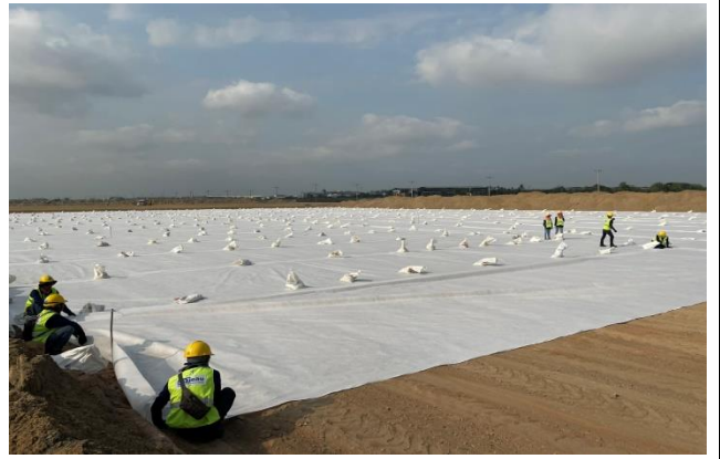
งานปูผ้า Geotextile
