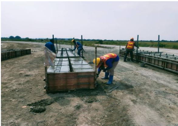
เทคอนกรีตฐาน รั้วกันพื้นที่ระหว่าง Air Side และ Land Side
