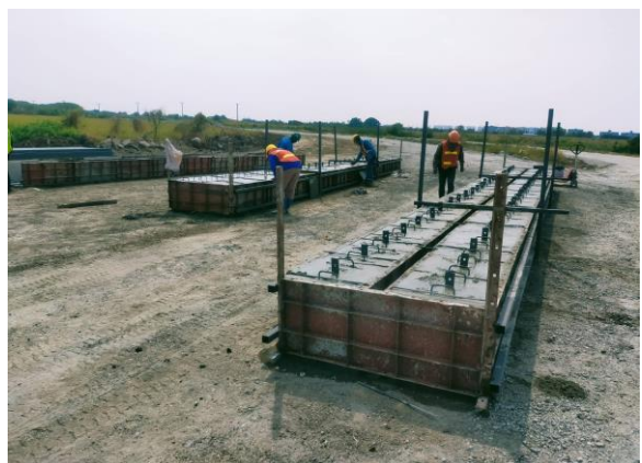
เทคอนกรีตฐาน รั้วกันพื้นที่ระหว่าง Air Side และ Land Side
